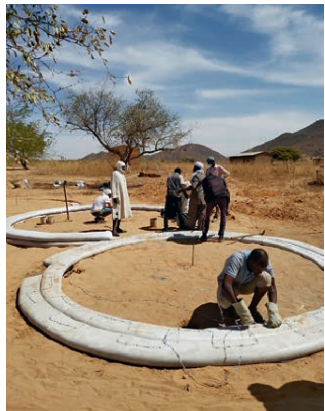
Der Einsatz der innovativen SuperAdobe Bautechnik ermöglicht günstiges und ans Klima angepasstes Bauen
